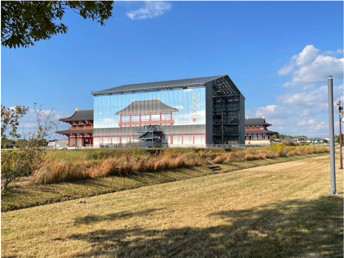
10. 第一次大極殿院南門と修復中の東楼
